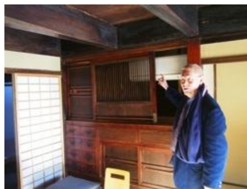
エアコンは格子戸に入れて隠す
